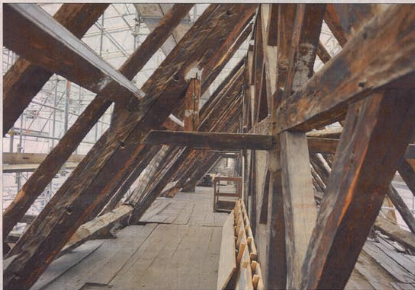
La charpente de l'aile ouest. Une œuvre exceptionnelle en croix et en double croix de Saint-André, originaire de Bourgogne.
